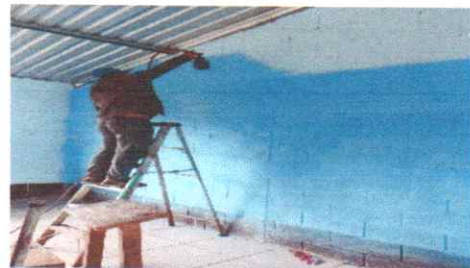
Foto 6: pintura en muros en interiores y exteriores
