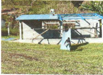
Foto1: colocación de lámina
