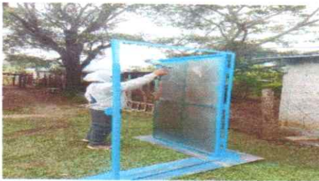
Foto 3: elaboración de puerta de metal
