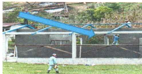
Foto 10: repello de paredes
