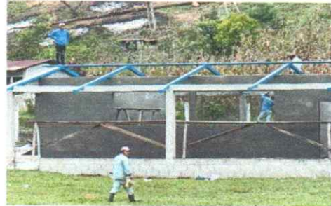
Foto 2: estructura de techo
