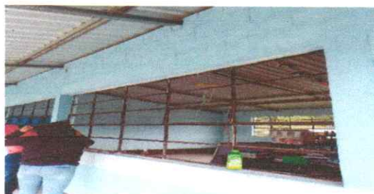
Foto 8: mantenimiento de estructuras de ventanas
