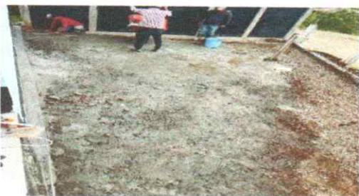
Foto 9: reparación de plancha de patio
