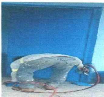
Foto7: Lijado y pintado en servicios sanitarios
