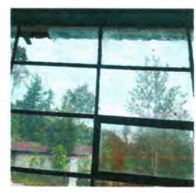
Foto 8: para cambio de vidrios y mantenimiento de estructuras de ventanas
