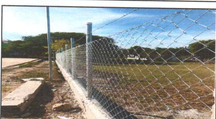
Foto 4: Re reparará todo el perímetro de la escuela para un mejor cuidado del centro educativo.
