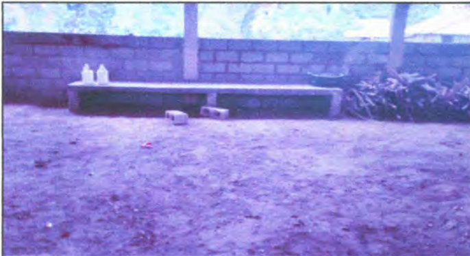
Foto 1: Remozamiento para la cocina a la cual se aplicará una sustitución de piso de torta de concreto, Sustitución de pila de cemento de un lavadero, Sustitución de plancha de metal de 3 hornillas
