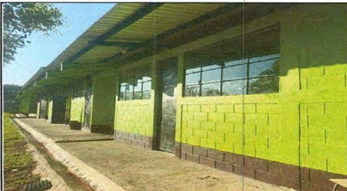
FOTO 3: SUSTITUCIÓN DE ESTRUCTURA DE METAL DE VENTANAS, SUSTITUCIÓN DE VIDRIOS
