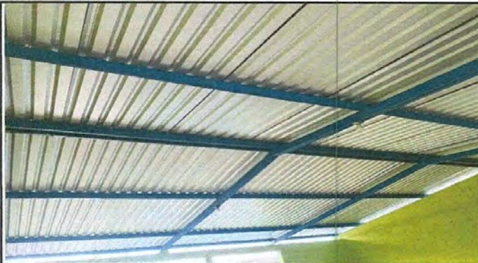
FOTO 1: SUSTITUCIÓN DE LÁMINA POR LÁMINA TROQUELADA CALIBRE 26
