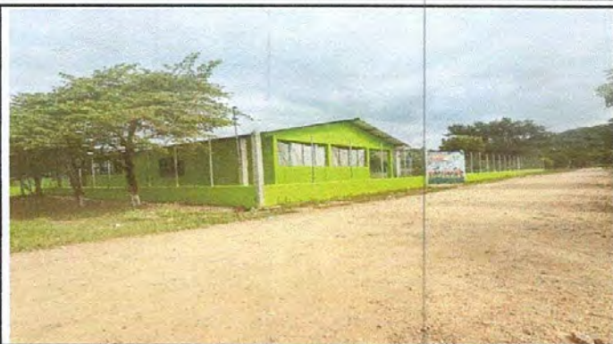
FOTO 7: REPARACIÓN DE MURO PERIMETRAL DE BLOCK
