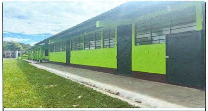
FOTO 6: PINTURA EN MUROS EXTERIORES E INTERIORES
