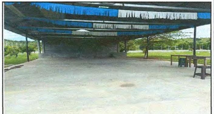
FOTO4: SUSTITUCIÓN DE PISO DE CONCRETO
