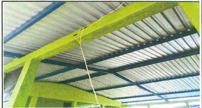
FOTO: MANTENIMIENTO A LA ESTRUCTURA DE SOPORTE DE METAL
