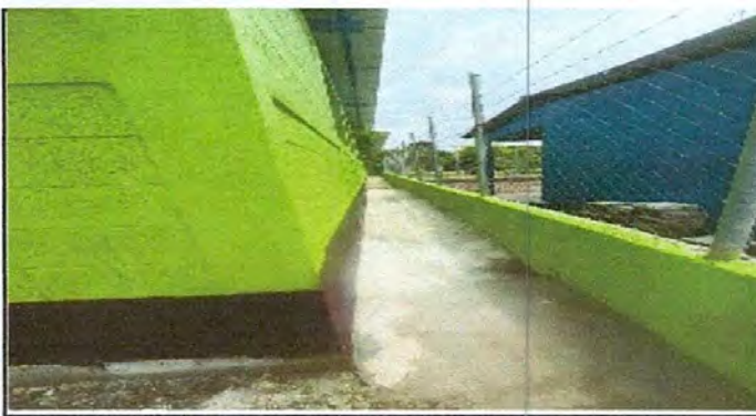
FOTO 5: REPARACIÓN DE CUNETA DE CONCRETO
