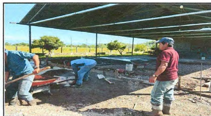
FOTO4: SUSTITUCIÓN DE PISO DE CONCRETO
