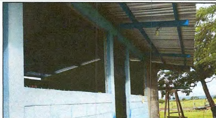
FOTO 1: SUSTITUCIÓN DE LÁMINA POR LÁMINA TROQUELADA CALIBRE 26
