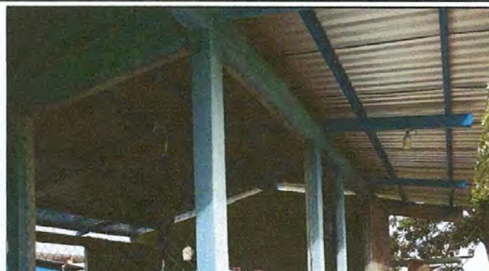
FOTO: MANTENIMIENTO A LA ESTRUCTURA DE SOPORTE DE METAL
