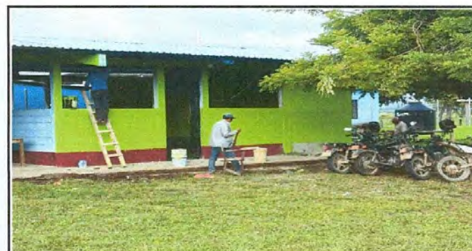
FOTO 6: PINTURA EN MUROS EXTERIORES E INTERIORES
