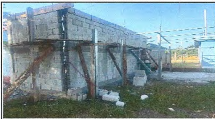
FOTO 8: REPARACIÓN DE MURO DE CONTENCIÓN
