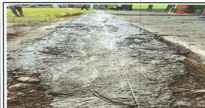
FOTO 5: REPARACIÓN DE CUNETA DE CONCRETO
