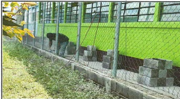
FOTO 7: REPARACIÓN DE MURO PERIMETRAL DE BLOCK
