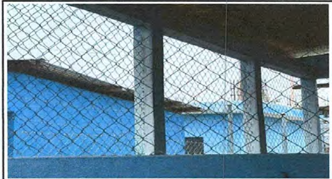
FOTO 3: SUSTITUCIÓN DE ESTRUCTURA DE MATA DE VENTANAS, SUSTITUCIÓN DE VIDRIOS
