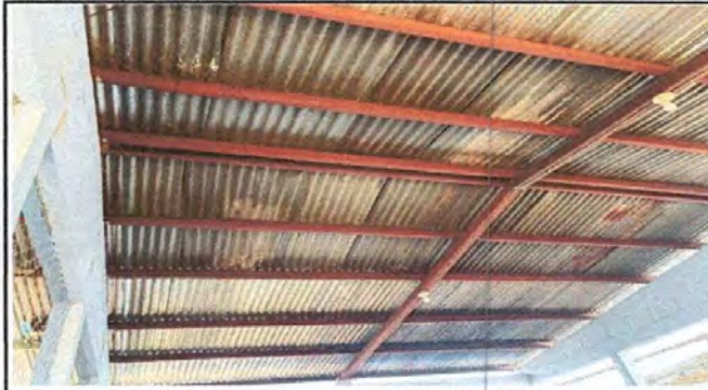
FOTO 1: SUSTITUCIÓN DE LÁMINA POR LÁMINA TROQUELADA CALIBRE 26
