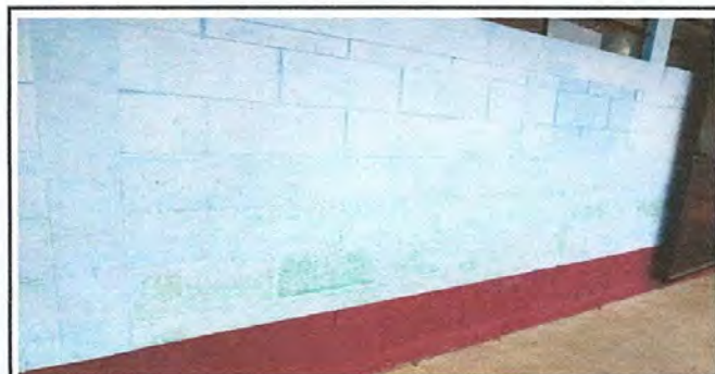
FOTO 6: PINTURA EN MUROS EXTERIORES E INTERIORES
