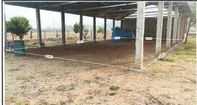
FOTO4: SUSTITUCIÓN DE PISO DE CONCRETO
