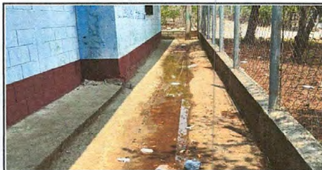
FOTO 5: REPARACIÓN DE CUNETA DE CONCRETO
