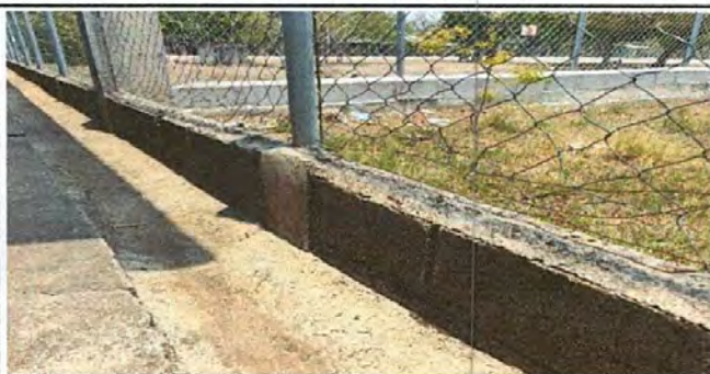
FOTO 7: REPARACIÓN DE MURO PERIMETRAL DE BLOCK
