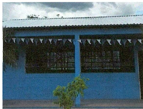
Foto 6: Sustitución de estructura de techo
