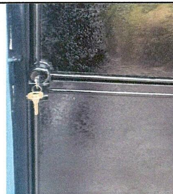
Foto 4: Sustitución de chapas
