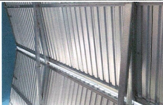
Foto 5: Sustitución de estructura de techo
