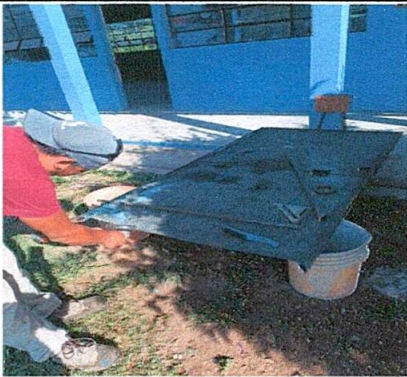
Foto 3: Reparación de puertas
