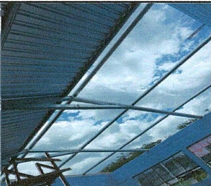
Foto 5: Sustitución de estructura de techo
