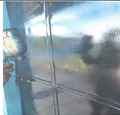
Foto 4: Sustitución de chapas
