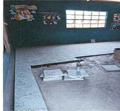
Foto 2: Sustitución de piso de concreto por piso de granito
