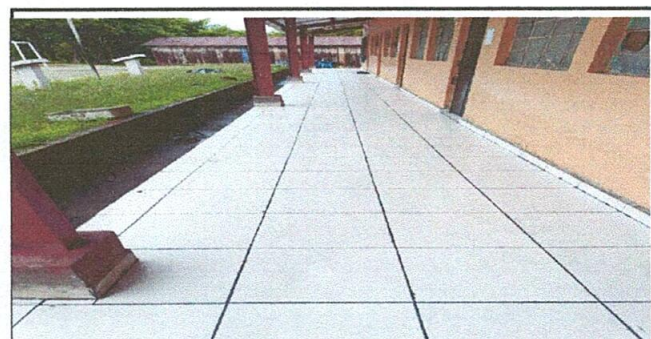
Foto No. 6 Sustrucción de piso de cemento por piso ya terminada.
