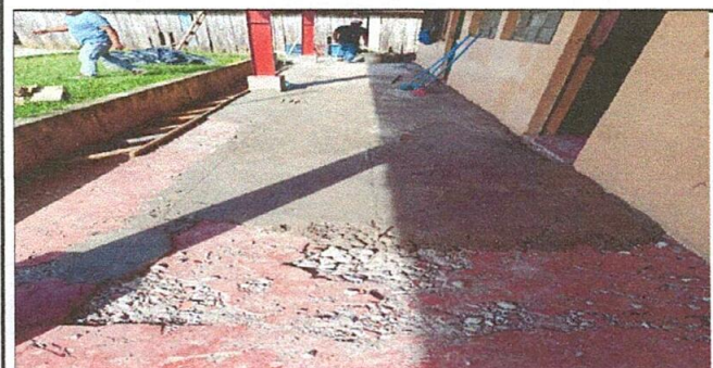
Foto No. 5 Sustrucción de torta de cemento por piso
