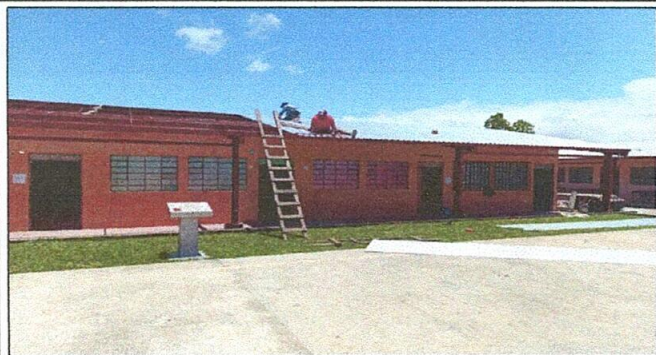
Foto No. 1 Sustrucción de lámina por lámina
