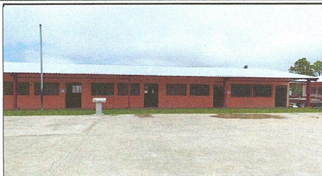
Foto No. 2 Sustrucción terminada de lámina por lámina.
