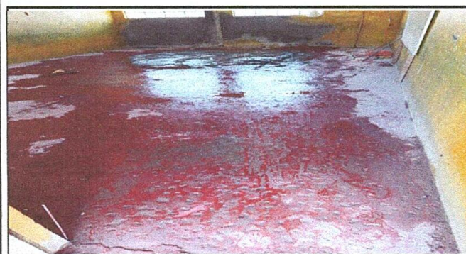
Foto No. 3 Sustrucción de torta de cementeo por piso
