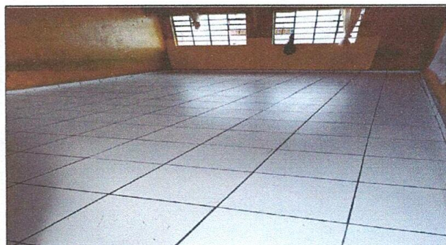
Foto No. 4 Sustrucción de piso de cemento por piso ya terminada.
