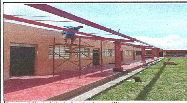
Foto No. 5 Mantenimiento de estructura metálica.
