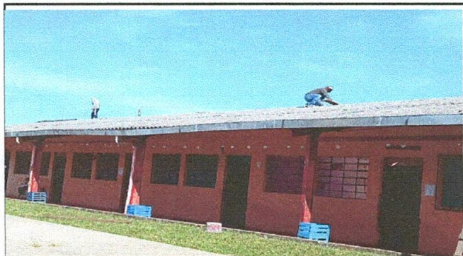
Foto No. 1 Sustitución de lámina por lámina
