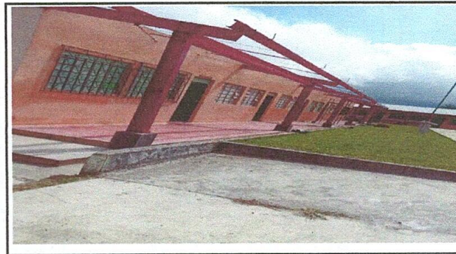
Foto No. 4 Sustitución de base, ya terminada y pintura.
