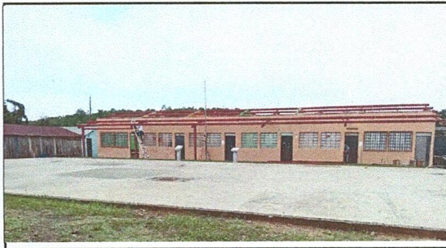
Foto No. 2 Sustitución terminada de lámina por lámina.
