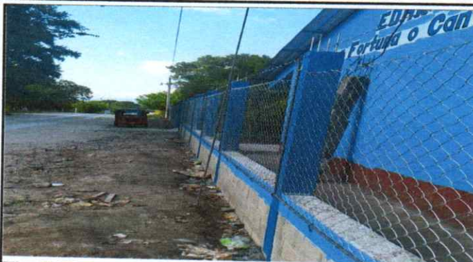
FOTO 8: SUSTITUCIÓN DE MURO PERIMETRAL: 4 HILADAS DE BLOCK, POSTES DE CONCRETO Y MALLA DE 1.50 METROS DE ALTURA, CON DOS HILAS DE ALAMBRE ESIPIGADO EN LA PARTE SUPERIOR
