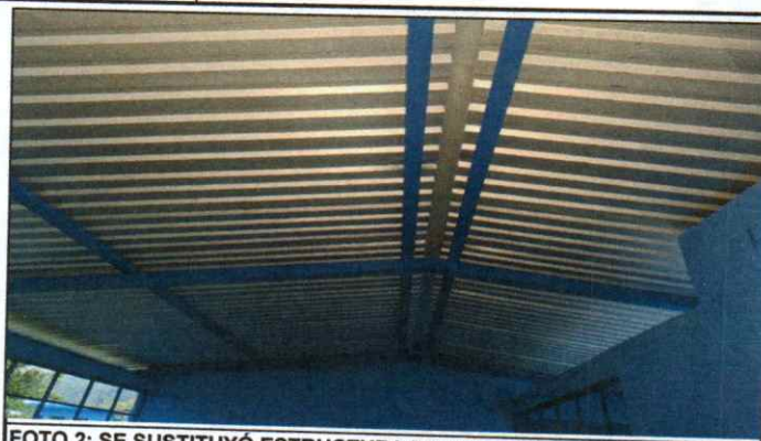
FOTO 2: SE SUSTITUYÓ ESTRUCTURA DE MADERA POR ESTRUCTURA DE METAL. SE OCUPARON TUBOS CUADRADOS DE 4 X 4" CH 16 Y TUBOS RECTANGULARES DE 3X2" CH 16
