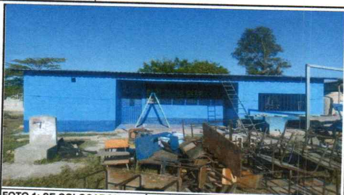
FOTO 1: SE COLOCARON 24 LÁMINAS TROQUELADAS CALIBRE 26
