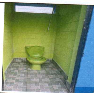
FOTO 6: SE SUSTITUYÓ PISO DE TORTA DE CONCRETO POR PISO CERÁMICO EN LOS SERVICIOS SANITARIOS. SE SUSTITUYERON 6 TAZAS BLANCAS POR TAZAS VERDES DE CERÁMICA
