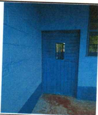
FOTO 3: SE APLICÓ PINTURA ANTICORROSIVA CELCO R-15 SECADO RÁPIDO A 8 PUERTAS, DE COLOR AZUL
