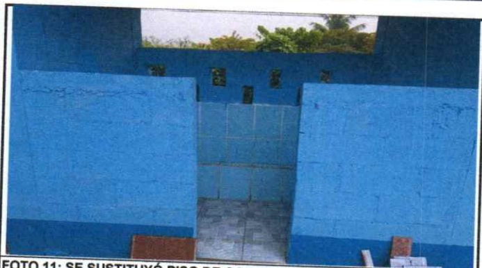
FOTO 11: SE SUSTITUYÓ PISO DE CONCRETO POR PISO CERÁMICO EN EL MINGITORIO
