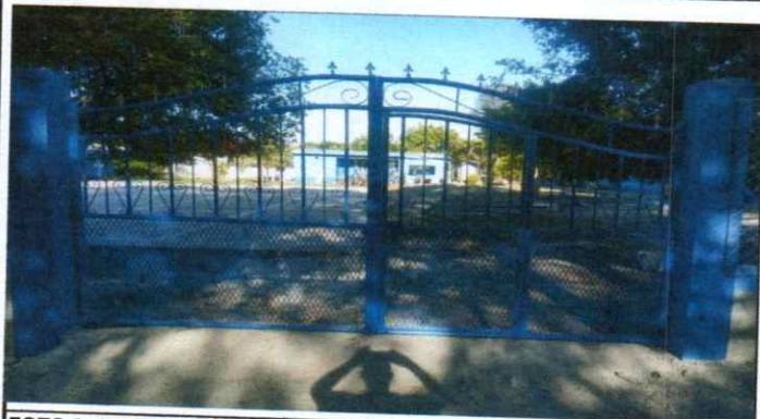
FOTO 9: SUSTITUCIÓN DE PORTÓN. SE PAGARON LOS SERVICIOS PARA LA ELABORACIÓN E INSTALACIÓN DE UN PORTÓN DE 3.75 M DE ANCHO POR 2.30 M DE ALTO, CON TUBO PROCESO DE 1 1/4" EN COLOR AZUL
