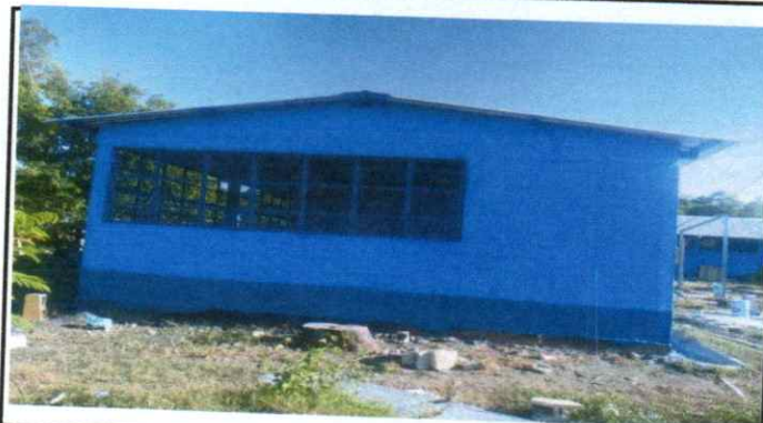
FOTO 4: SE APLICÓ PINTURA ANTICORROSIVA CELCO R-15 SECADO RÁPIDO DE COLOR AZUL A 8 VENTANALES, APROXIMADAMENTE 30 METROS CUADRADOS
