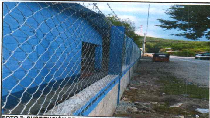
FOTO 7: SUSTITUCIÓN DE MURO PERIMETRAL : 5 HILADAS DE BLOCOK, POSTES DE CONCRETO Y MALLA DE 1.50 METROS DE ALTURA, CON DOS HILAS DE ALAMBRE ESIPIGADO EN LA PARTE SUPERIOR
