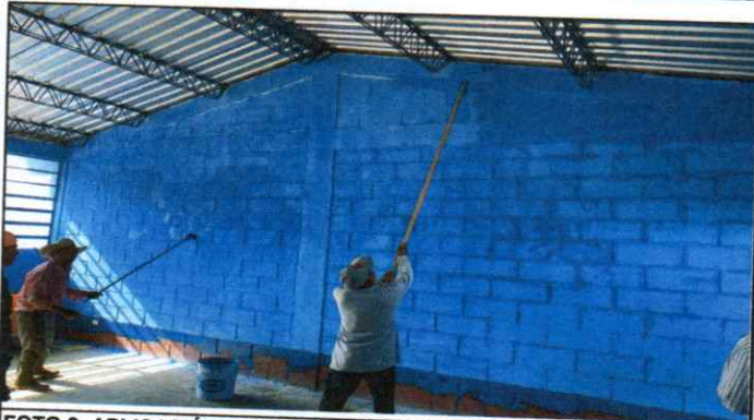
FOTO 3: APLICACIÓN DE PINTURA EN PAREDES INTERIORES
