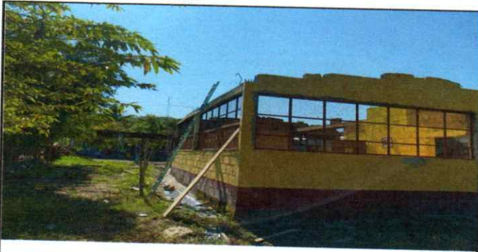
FOTO 9: APLICACIÓN DE PINTURA EN LAS PAREDES INTERIORES Y EXTERIORES DE LOS SERVICIOS SANITARIOS
