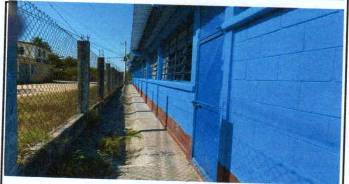
FOTO 4: APLICACIÓN DE PINTURA EN PAREDES EXTERIORES
