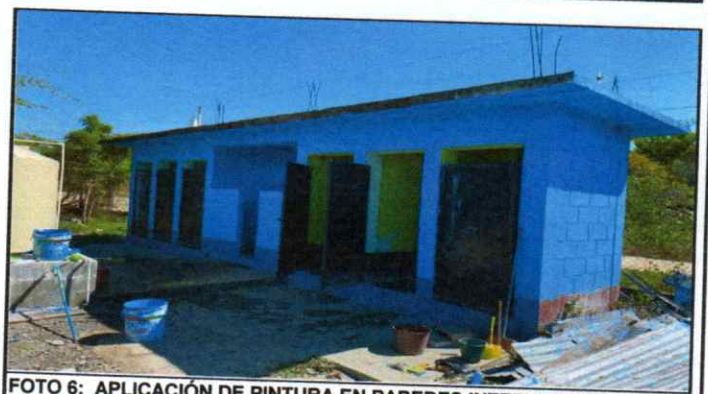
FOTO 6: APLICACIÓN DE PINTURA EN PAREDES INTERIORES Y EXTERIORES EN MODULO DE SERVICIOS SANITARIOS
