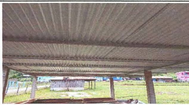
Foto 2: sustitución de estructura de techo.
