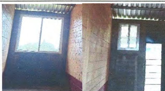
Foto 4: sustitución de ventanas y balcones.
