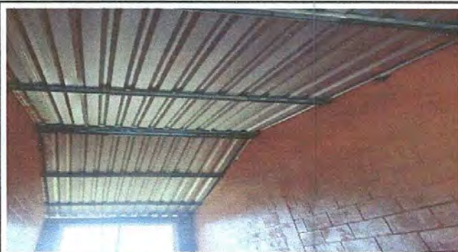
Foto1: sustitución de cubierta de lámina
