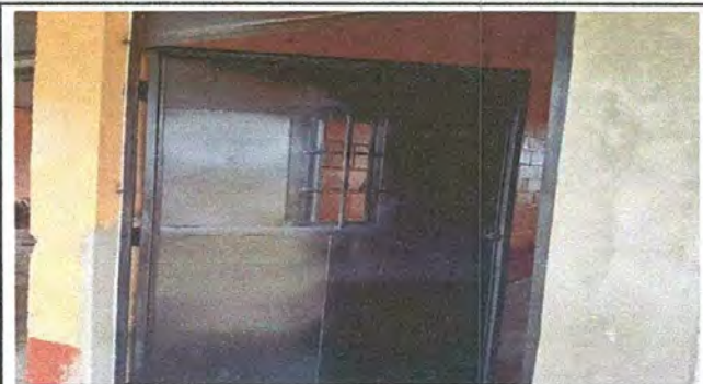
Foto 3: sustitución de puerta de metal.
