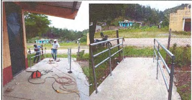
Foto 10: MANTENIMIENTO A BARANDAS
