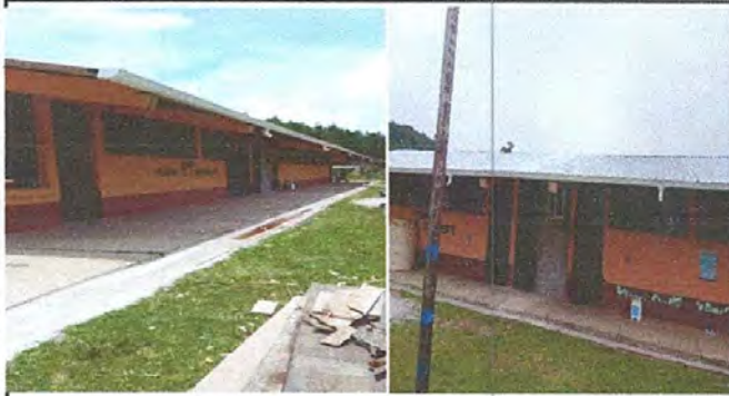
Foto 7. CUNETA DE CONCRETO.
