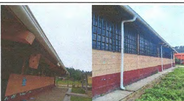
Foto 6: canales y bajadas de agua pluvial.
