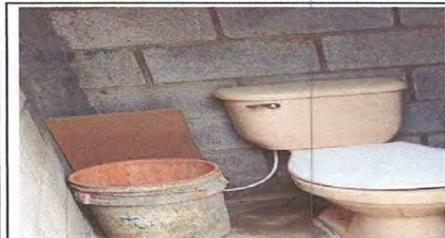
Foto 9 : SUSTITUCIÓN DE ACCESORIOS, HINODOROS (contra llaves, tubo de abasto y tanques)
