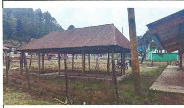
Foto 2: sustitución de estructura de techo.
