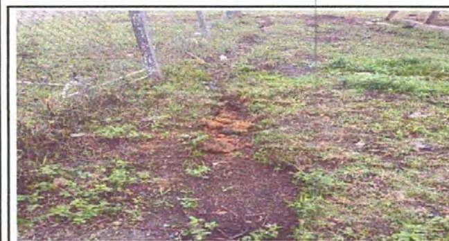
Foto 11: RED DE AGUA POTABLE. SUSTITUCIÓN DE TUBERÍA PRINCIPAL
