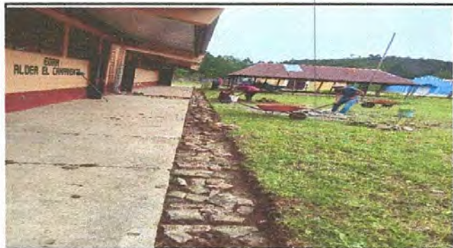
Foto 7. CUNETA DE CONCRETO.
