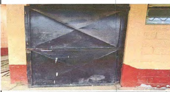
Foto 3: sustitución de puerta de metal.
