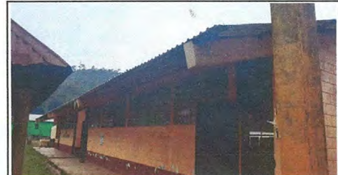
Foto 6: canales y bajadas de agua pluvial.
