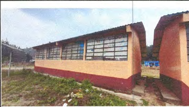
Foto 1: sustitución de cubierta de lámina
