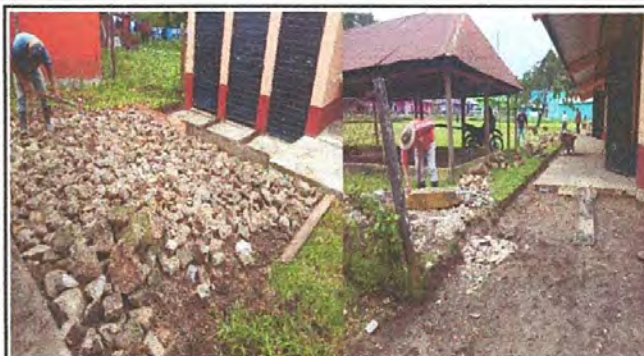
Foto 8 REPARACIÓN DE BANQUETAS Y RAMPA DE CONCRETO
