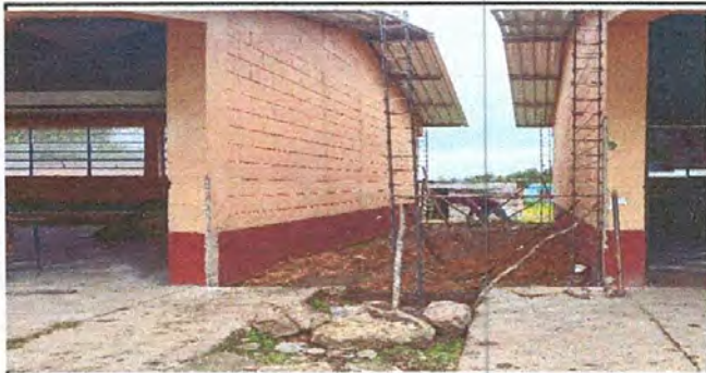
Foto 5: sustitución de piso de torta de concreto
