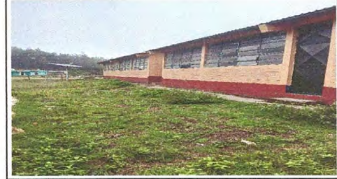
Foto 4: sustitución de ventanas y balcones.
