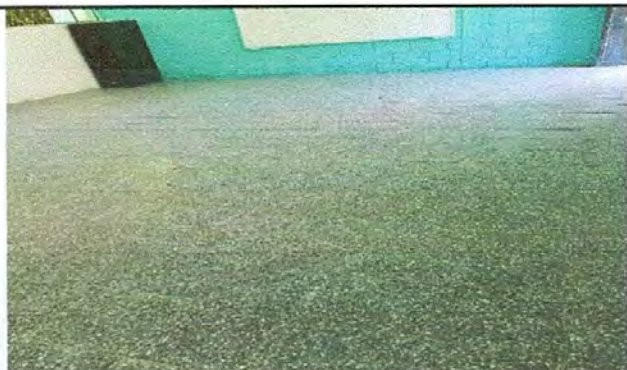
Foto 3: SUSTITUCIÓN DE PISO DE GRANITO
