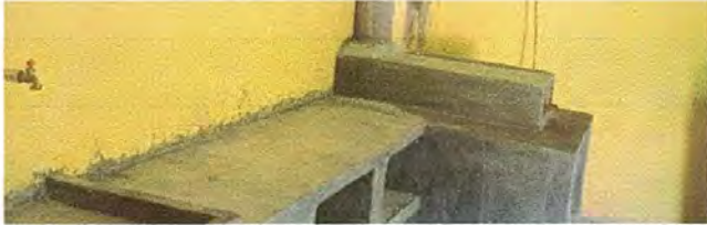
Foto1: SUSTITUCIÓN DE PLANCHA DE 3 HORNILLAS
