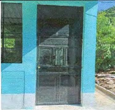
Foto 3: SUSTITUCIÓN DE PUERTA DE MADERA POR PUERTA DE METAL
