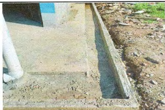
Foto 5: CUNETA DE CONCRETO
