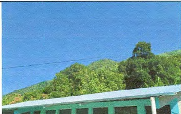
Foto1: CUBIERTA DE LÁMINA
