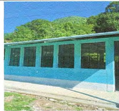
Foto 4: SUSTITUCIÓN DE VENTANA DE MADERA POR VENTANA DE METAL MAS VIDRIO
