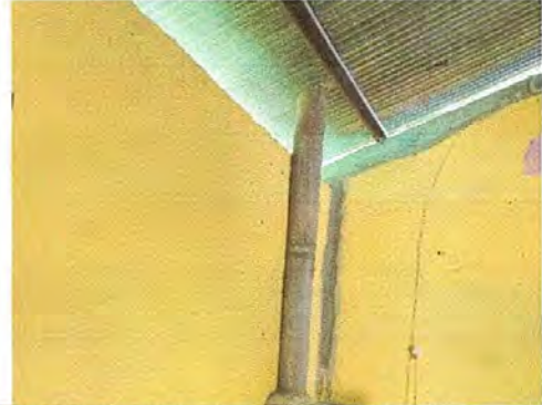
Foto 2: SUSTITUCIÓN DE CHIMENEA DE CONCRETO
