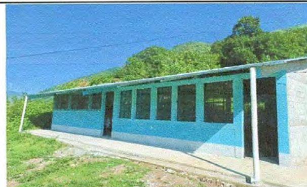
Foto 4: CANALES Y BAJADA DE AGUA PLUVIAL
