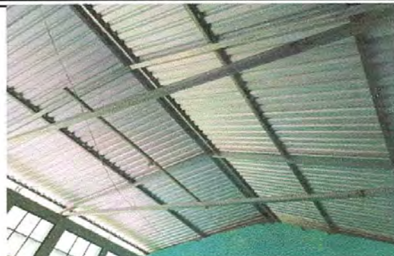
Foto 2: ESTRUCTURA DE TECHO
