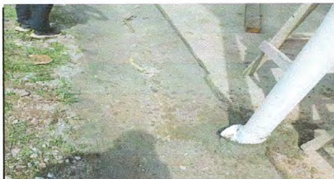
Foto 5: CUNETA DE CONCRETO
