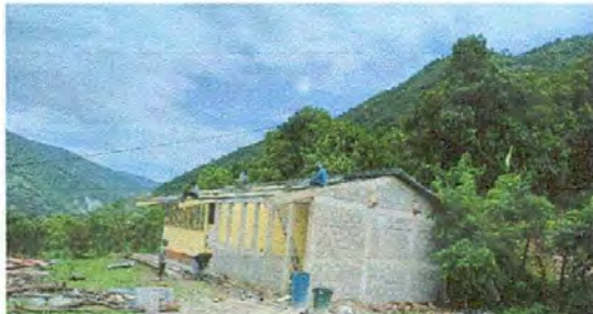
Foto 1: CUBIERTA DE LÁMINA
