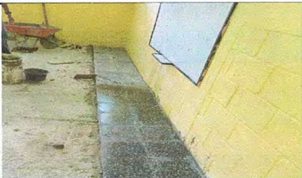
Foto 3: SUSTITUCIÓN DE PISO DE GRANITO
