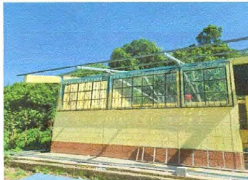
Foto 2: ESTRUCTURA DE TECHO
