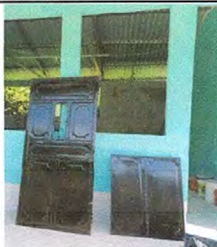
Foto 3: SUSTITUCIÓN DE PUERTA DE MADERA POR PUERTA DE METAL
