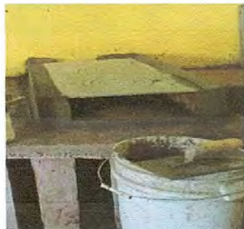
Foto 1: SUSTITUCIÓN DE PLANCHA DE 3 HORNILLAS
