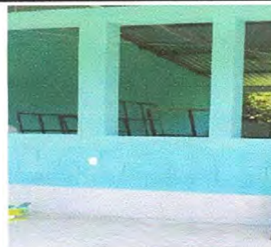
Foto 4: SUSTITUCIÓN DE VENTANA DE MADERA POR VENTANA DE METAL MAS VIDRIO
