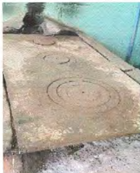
FOTO 7: SUSTITUCIÓN PLANCHA DE 3 HORNILAS
