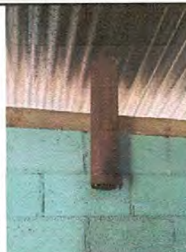
FOTO 8: SUSTITUCIÓN CHIMENEA DE CONCRETO
