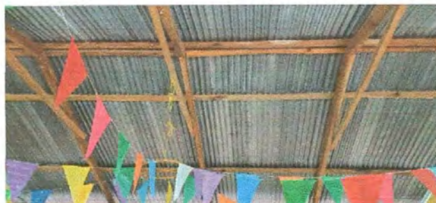
FOTO 2: ESTRUCTURA DE TECHO
