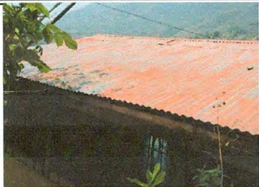
FOTO 1: CUBIERTA DE LÁMINA
