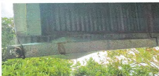
FOTO 4: CANALES Y BAJADAS DE AGUA PLUVIAL
