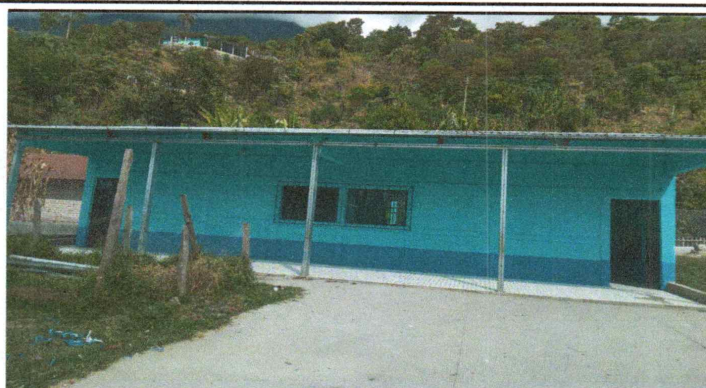
Foto 2: Ventanas, canales y pintura
