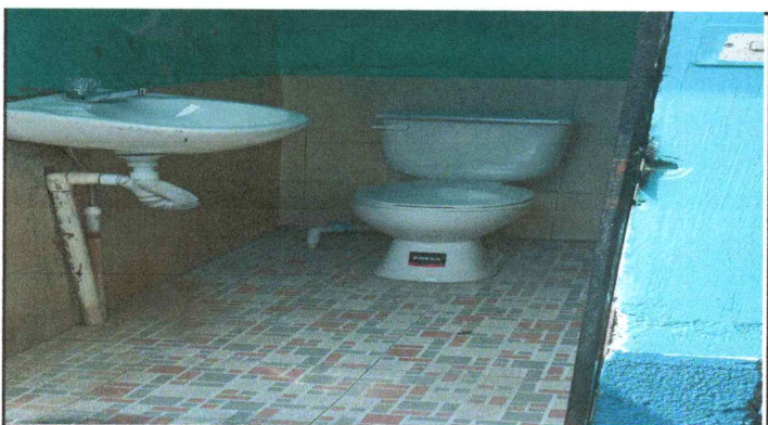
Foto 3: Sustitucion de accesorios
