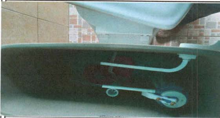
Foto 3: Sustitucion de accesorios
