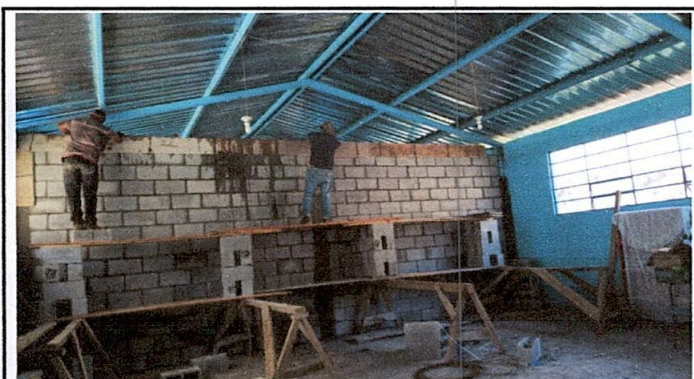
Foto 3: División de aulas
