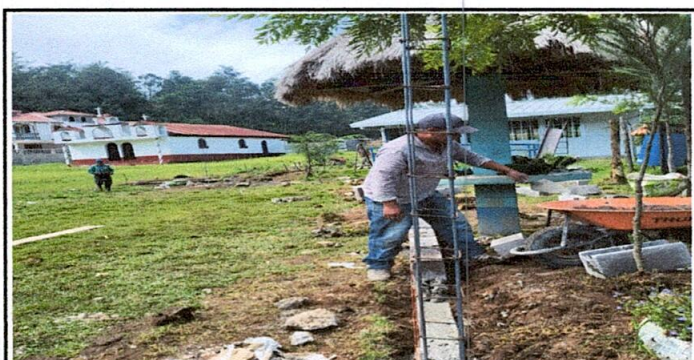
Foto 5: Sustitución de muro perimetral
