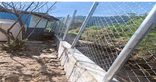
Foto 4: MURO PERIMETRAL FINALIZADO
