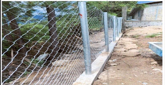
Foto 3: MURO PERIMETRAL FINALIZADO
