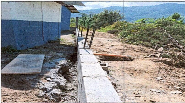
Foto 3: MEJORAMIENTO DE MURO PERIMETRAL
