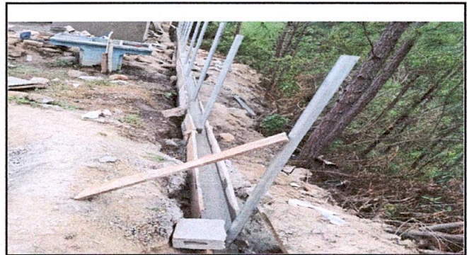
Foto 4: MEJORAMIENTO DE MURO PERIMETRAL
