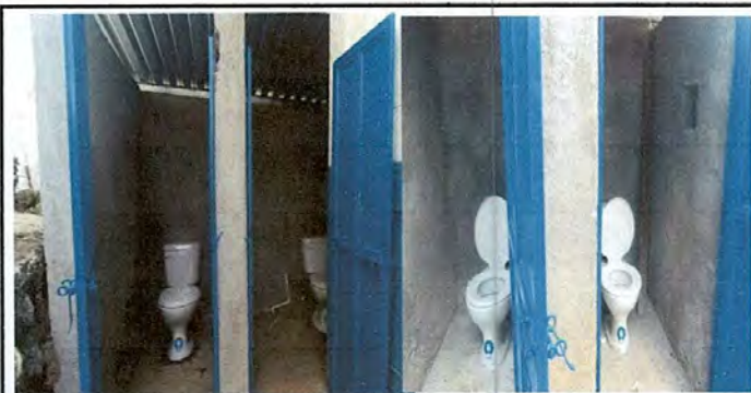
Foto 5: Sanitarios: inodoros instalados
