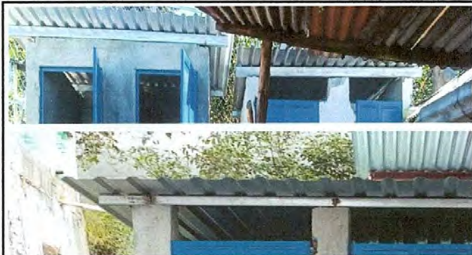
Foto 2: Costaneras instaladas.
