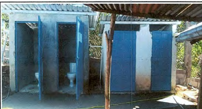
Foto 3: Sanitarios: lamina, costaneras y puertas instaladas
