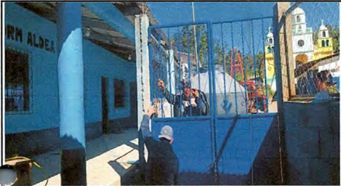
Foto 7: Porton: sustitución de porton
