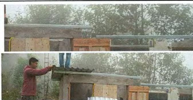
Foto 2: Sustitución de sostenimiento de reglas de madera por costaneras.
