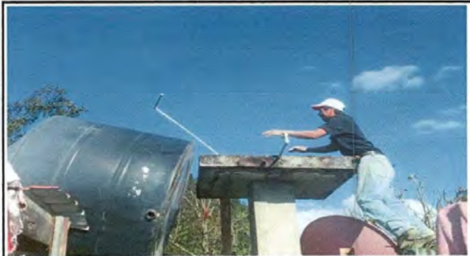
Foto 9: Deposito de agua: Sustitución de deposito de agua
