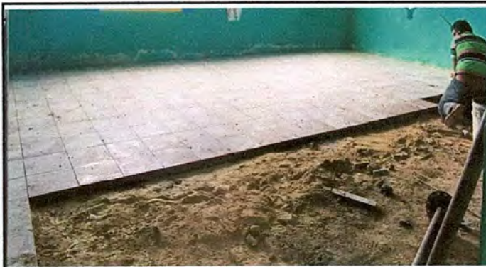
Foto 4: Pisos: sustitución de piso rustico por piso granito
