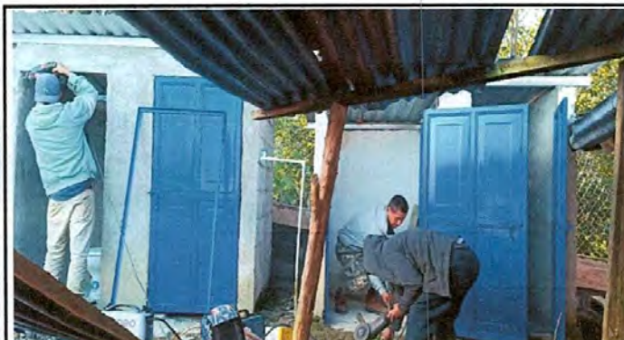
Foto 3: Sanitarios: Mejoramiento de servicios sanitarios techo y puertas
