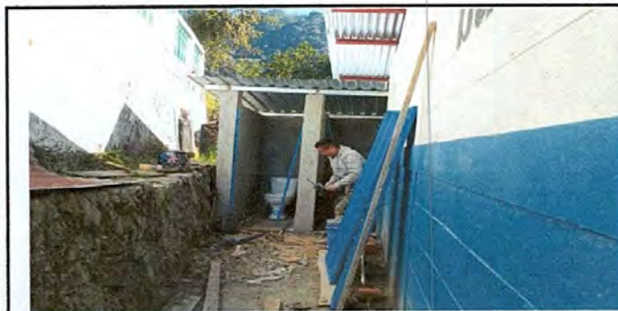
Foto 5 : Sustitución de inodoros
