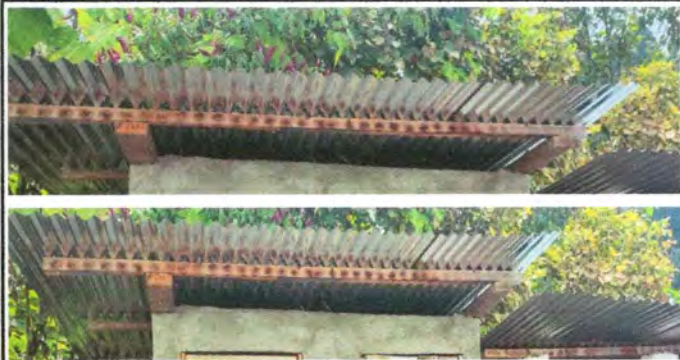
Foto 2: Sustitución de sostenimiento por costaneras.
