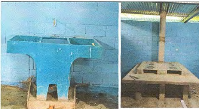
Foto 9: SUSTITUCIÓN DE PLANCHA, CHIMENEA Y PILA DE CEMENTO
