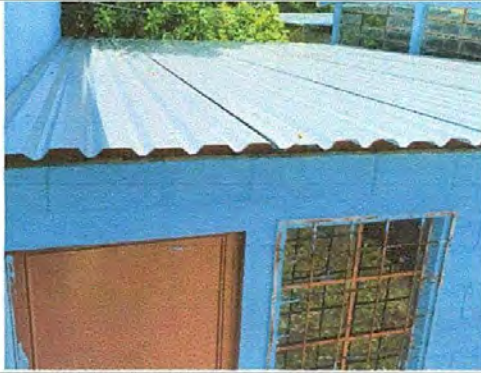
Foto 1: CUBIERTA DE LÁMINA
