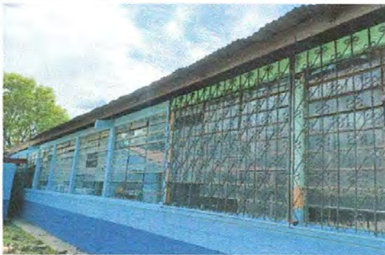
Foto 3: SUSTITUCIÓN DE VIDRIOS
