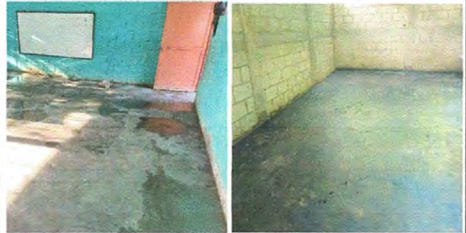
Foto 4: SUSTITUCIÓN DE PISO EN COCINA Y AULAS
