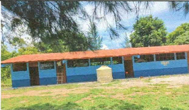
Foto 5: PINTURA EN MUROS EXTERIORES E INTERIORES
