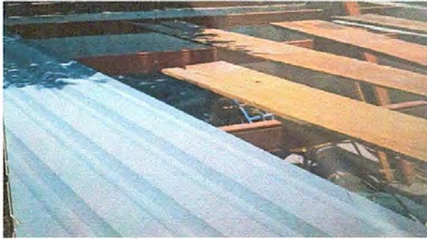
Foto1: CUBIERTA DE LÁMINA
