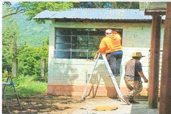
Foto 3: SUSTITUCIÓN DE VIDRIOS
