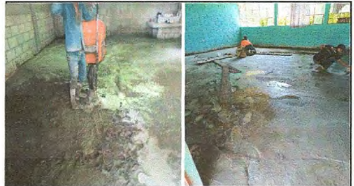
Foto 4: SUSTITUCIÓN DE PISO EN COCINA Y AULAS
