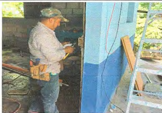
Foto 8: SUSTITUCIÓN DE CABLEADO ELÉCTRICO
