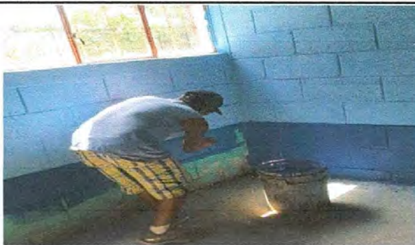
Foto 5: PINTURA EN MUROS EXTERIORES E INTERIORES
