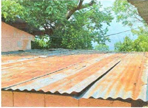
FOTO 1: CUBIERTA DE LÁMINA
