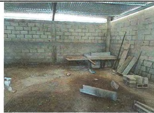
FOTO 4: SUSTITUCIÓN DE CEMENTO LÍQUIDO COCINA Y AULAS
