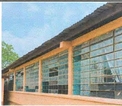
FOTO 3: SUSTITUCIÓN DE VIDRIOS
