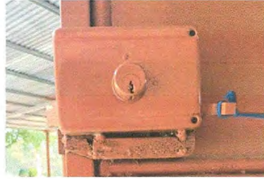
FOTO 2: SUSTITUCIÓN DE CHAPAS
