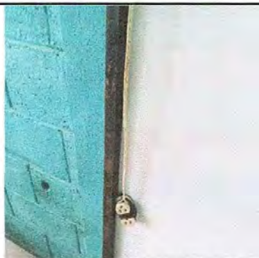
FOTO 8: SUSTITUCIÓN DE CABLEADO ELÉCTRICO
