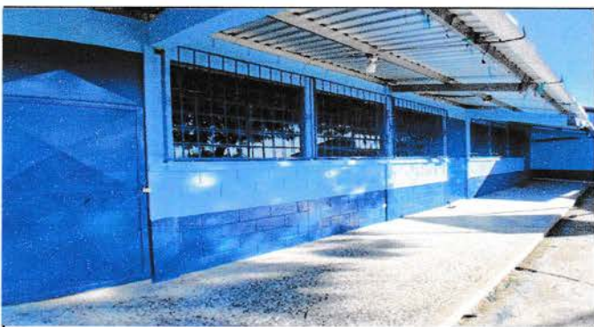
Foto 4: sustitución de vidrios y mejoramiento a balcones de metal
