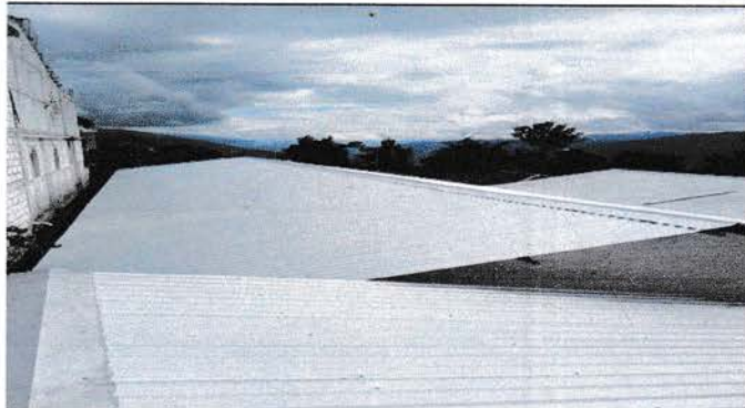
Foto 1: sustitución de lámina por lámina troquelada
