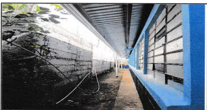
Foto 5: mejoramiento de bajadas de agua pluvial
