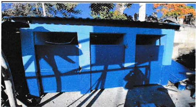
Foto 3: sustitución de puertas
