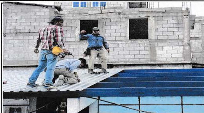
Foto1: Sustitucion de lamina por lámina troquelada
