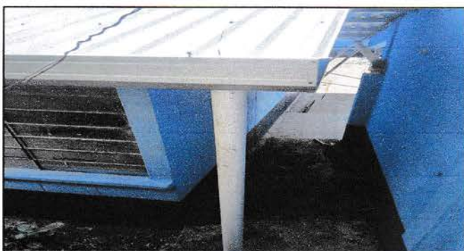
Foto 5: mejoramiento de bajada de agua pluvial
