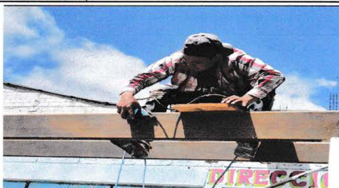
Foto 2: mantenimiento y sustitución de estructura de soporte de madera por metal.
