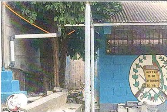
Foto 5: Cambio de canales bajada de agua
