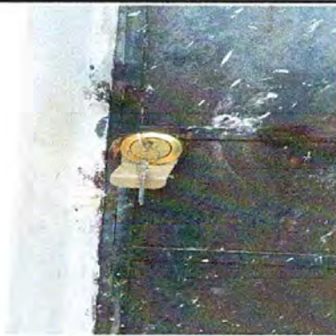
Foto 3: Cambio de accesorios de chapa
