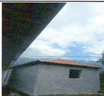
Foto 10: Reparación de repello
