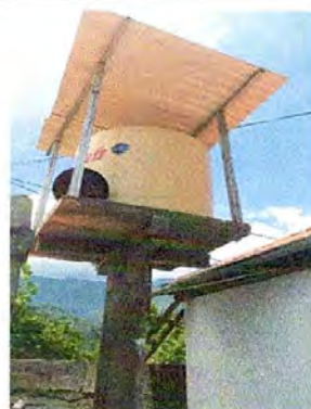
Foto 8: Sustitución de depósito de agua
