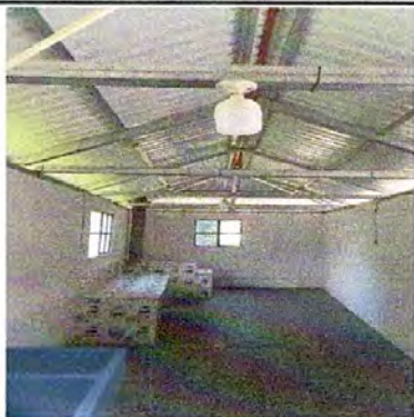
Foto 7: Reparación de sistema eléctrico
