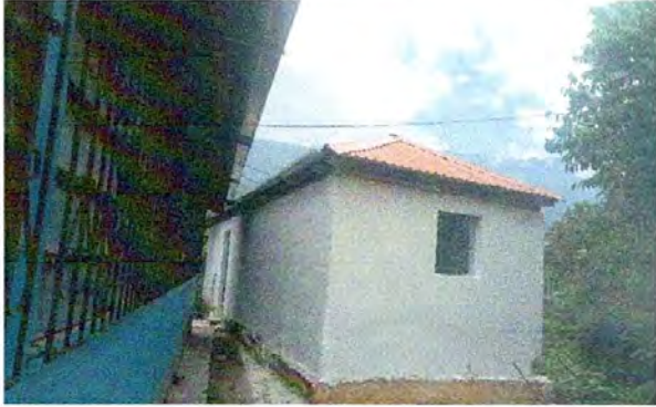
Foto 1: Cambio de lamina
