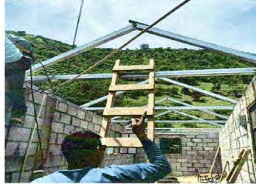
Foto 2: estructura metalica para cambio de techo
