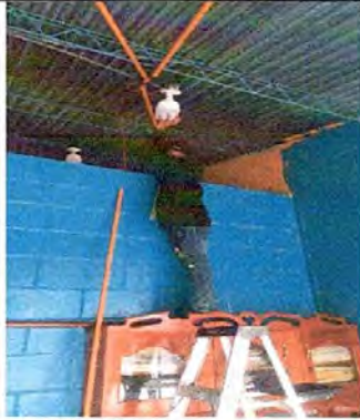
Foto7: Reparacion de sistema electrico
