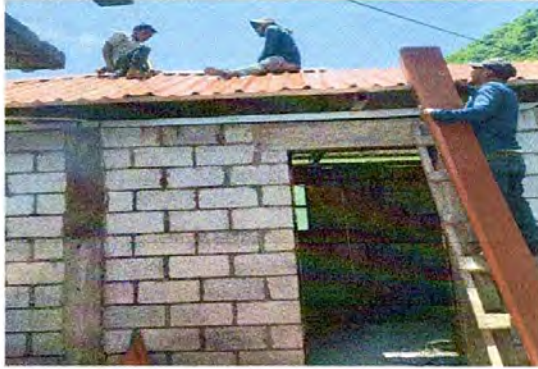
Foto1: Cambio de lamina
