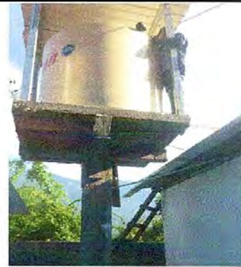
Foto 8: Sustitución de depósito de agua
