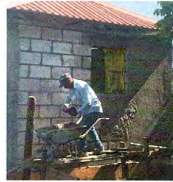
Foto 10: Reparación de repello
