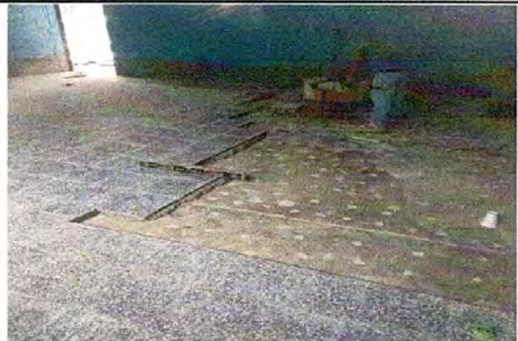
Foto 4: Cambio de piso, y colocacion de piso de granito, en aula escolar
