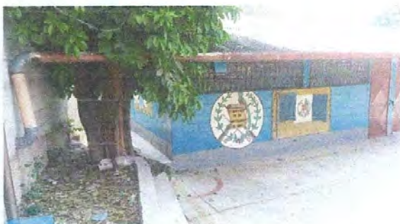
foto 5: sustitucion de canales de bajada de agua
