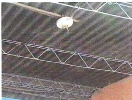
foto 7: reparacion de circuito eléctrico
