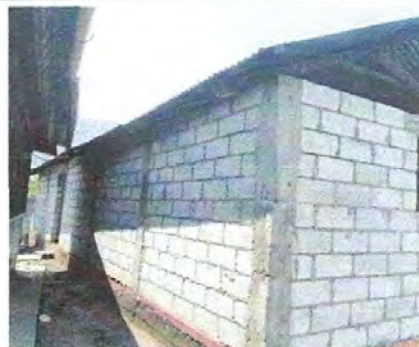
foto 10: reparación de repello
