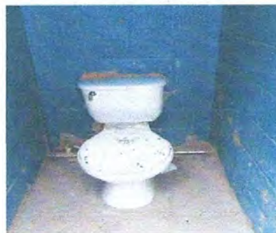
foto 6: sustitucion de servicios sanitarios
