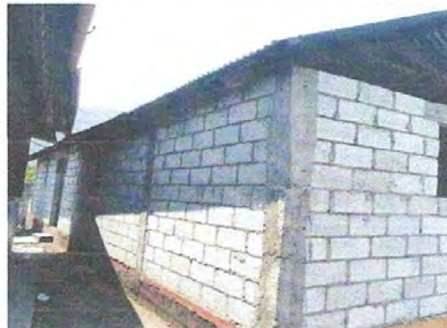
foto 2: Cambio de techo
