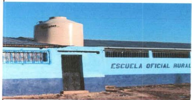
Foto 10: Depósito de Agua
