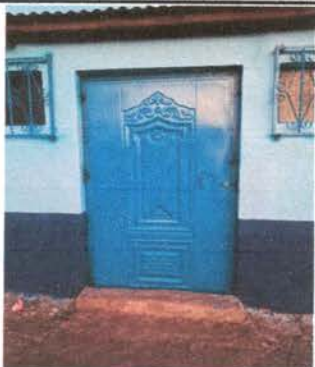
Foto1: Sustrucción de Puerta de Metal.
