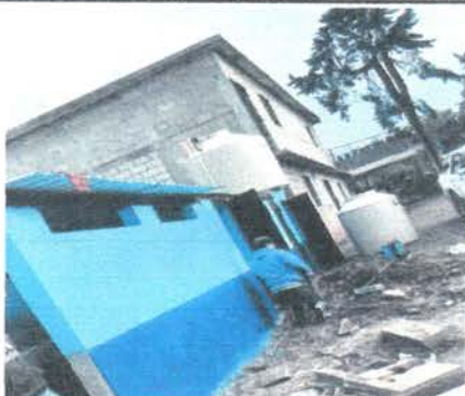
Foto 11: Sustitución de Depósito de agua
