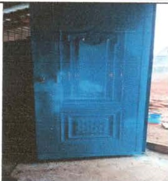
Foto1: Sustitución de Puerta de Metal.
