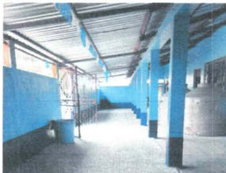
Foto 10: Depósito de Agua
