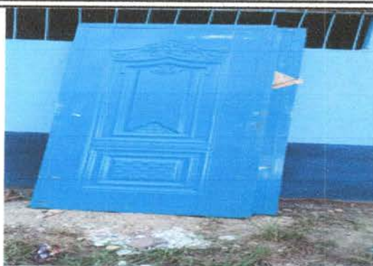
Foto 2: Sustitución de Portón.
