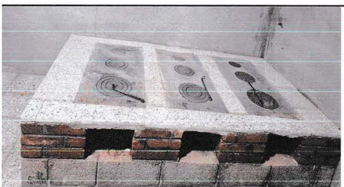
Foto 9: Mejoramiento de estufa rural completa
