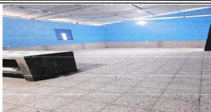
Foto8: Mejoramiento de piso de granito.
