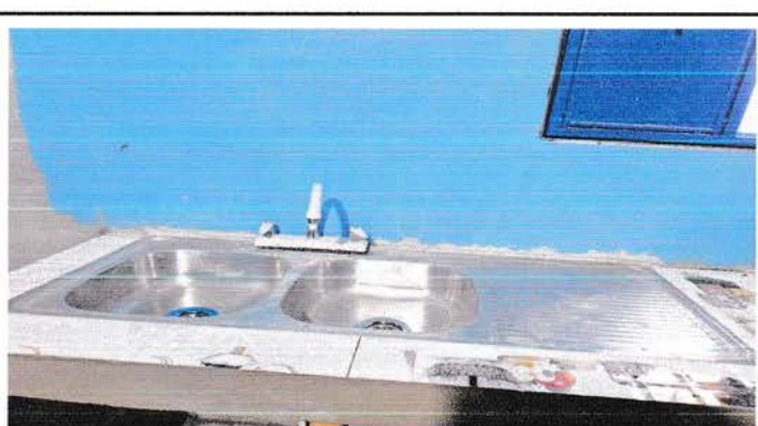
Foto 10: Mejoramiento de lavatrastos
