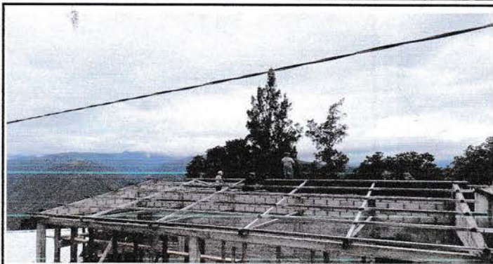
Foto1: Mejoramiento a la estructura de soporte de metal.
