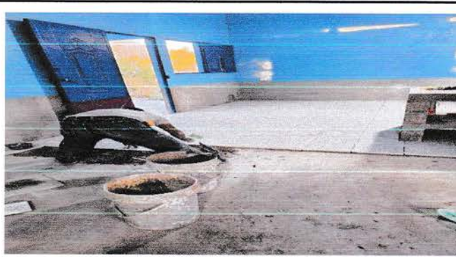
Foto8: Piso de cocina
