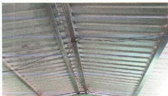
Foto 3: Sustrucción de soporte de madera por metal
