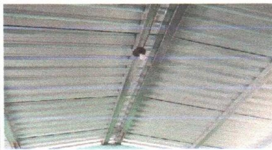
Foto 4: Sustrucción de soporte de madera por metal
