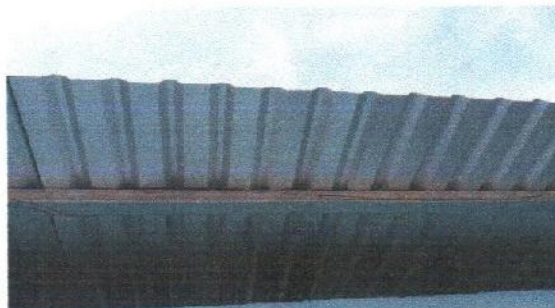
Foto 2: Sustrucción de soporte de madera por metal
