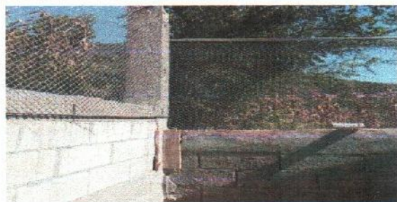
Foto 5: Reparación de muro perimetral de block con tubo hg malla galvanizada
