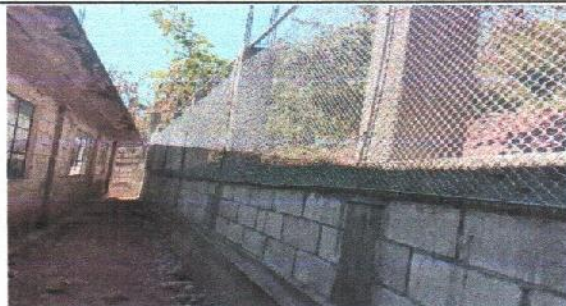
Foto 6: Reparación de muro perimetral de block con soleras intermedias y columnas
