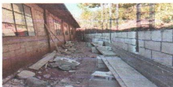
Foto 6: Reparación de muro perimetral de block con soleras intermedias y columnas
