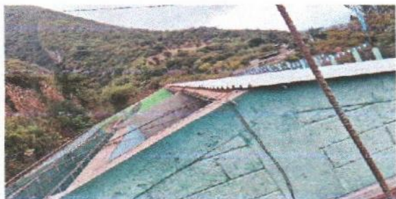
Foto 1: Sustrucción de lámina por lamina troquelada
