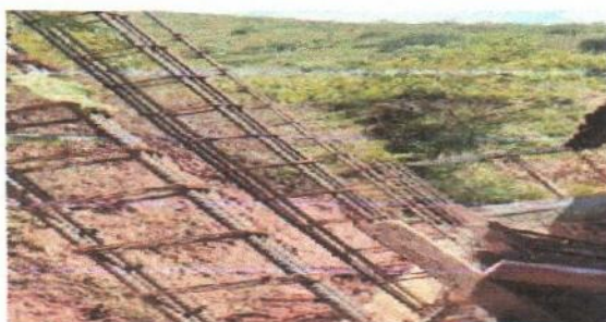
Foto 5: Reparación de muro perimetral de block con tubo hg malla galvanizada
