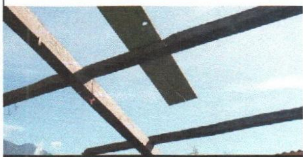
Foto 3: Sustrucción de soporte de madera por metal
