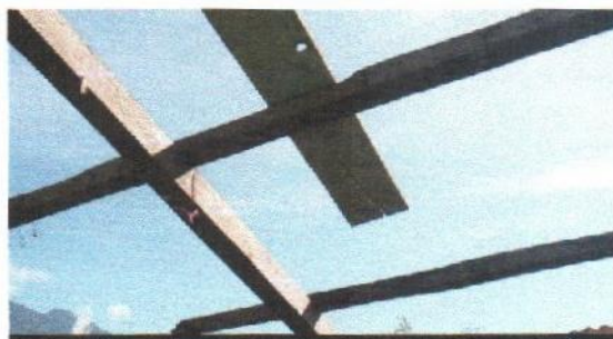
Foto 4: Sustrucción de soporte de madera por metal
