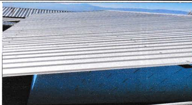
Foto1: Sustrucción de lámina, capote y elementos de fijación. Aula 1
