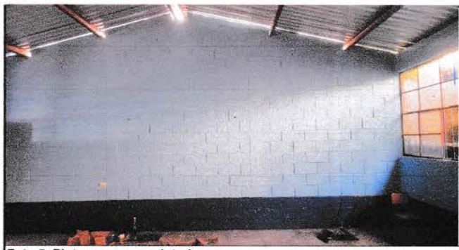
Foto 5: Pintura en muros interior
