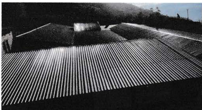
Foto 3: Sustrucción de lámina, capote y elementos de fijación en todas las aulas.
