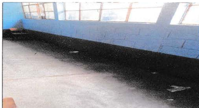
Foto 4: Pintura en muros interiores
