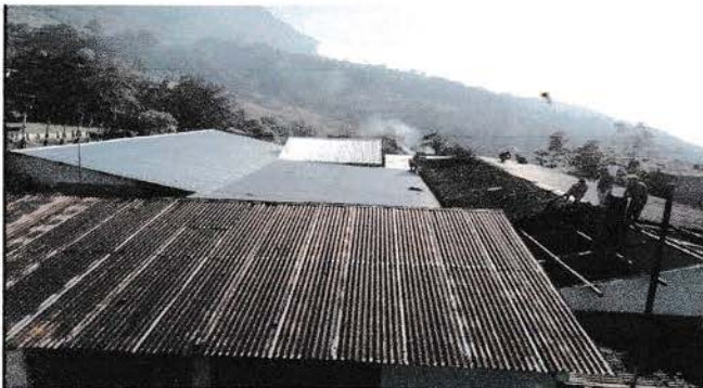
Foto 3: Sustitución de lámina de todas las aulas.
