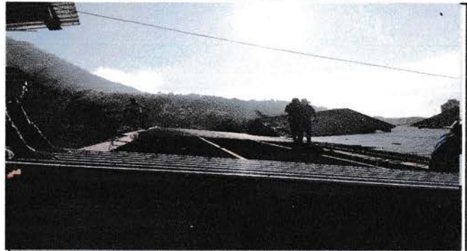
Foto 2: Sustitución de lamina: Aula 3
