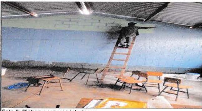
Foto 5: Pintura en muros interiores.
