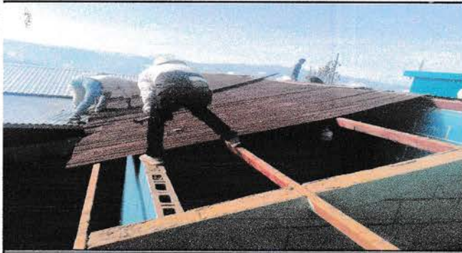
Foto1: Sustitución de lámina: Aula 1
