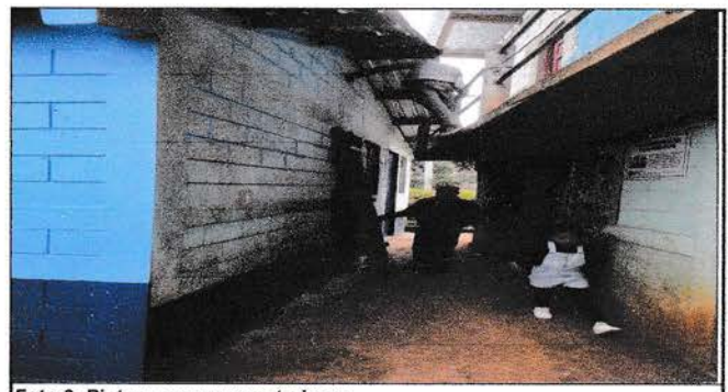
Foto 6: Pintura en muros exteriores.
