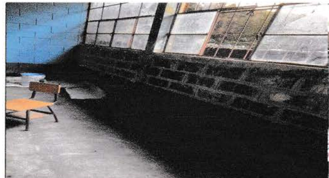
Foto 4: Pintura en muros interiores.
