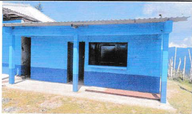
Foto 9: Sustitución de cubierta de lamina a cocina
