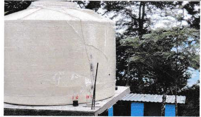
Foto 8: Sustitución de deposito de agua
