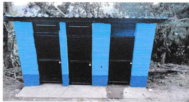
Foto 2: Mantemiento a estructura de puerta
