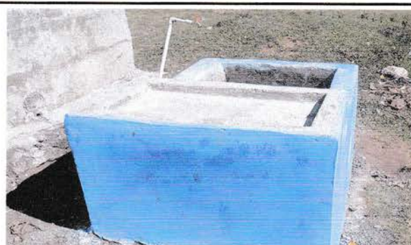
Foto 6: Sustrucción de llave de chorro
