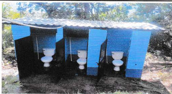
Foto 5: Sustrucción de accesorios de inodoros
