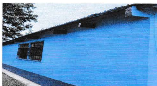
Foto 4: Pintura en muros exteriores
