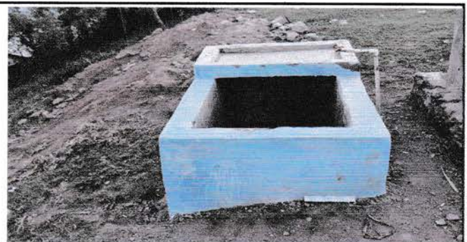
Foto 6: Sustitución de llave de chorro
