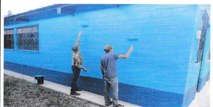
Foto 4: Pintura en muros exteriores
