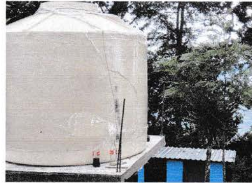
Foto 8: Sustitución de deposito de agua
