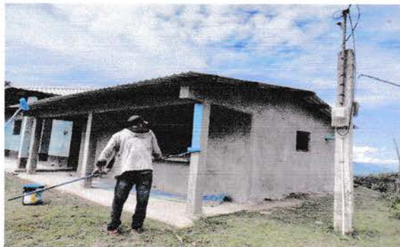
Foto 9: Sustitución de cubierta de lamina a cocina
