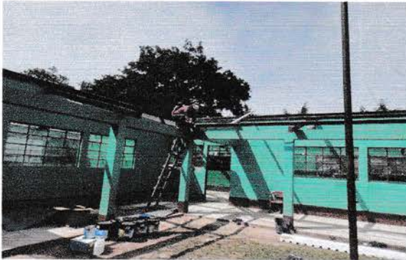
Foto 1: Sustitución de cubierta de lamina
