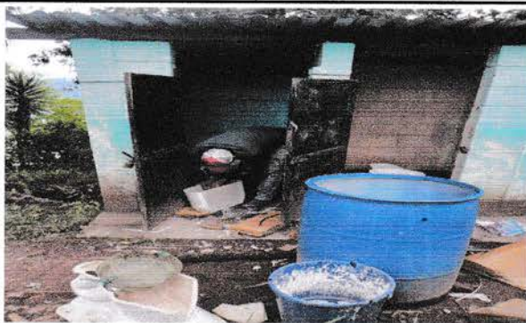
Foto 5: Sustitución de accesorios de inodoros
