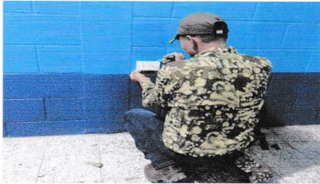
Foto 7: Sustitución de plafoneras
