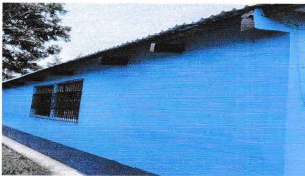
Foto 3: Sustitución de balcones y vidrios
