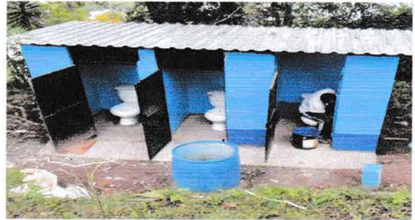
Foto 2: Mantemiento a estructura de puerta
