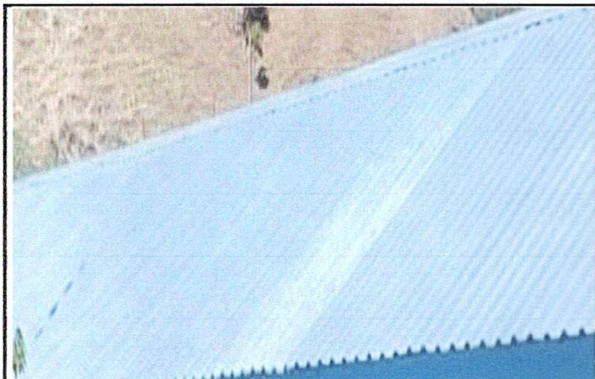
Foto 2: Sustitución de lamina finalizado
