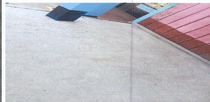
Foto 5: sustitución de piso finalizado
