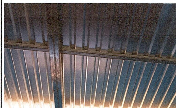
Foto 4: Sustitución de madera por metal finalizado
