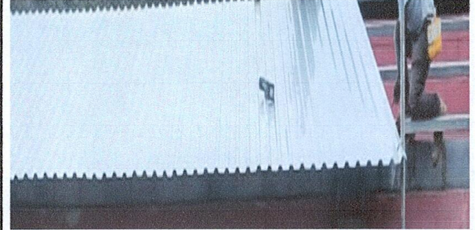
Foto 2: Sustrucción de lamina troquelada en proceso
