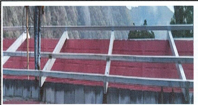
Foto 4: Sustrucción de madera por metal en proceso
