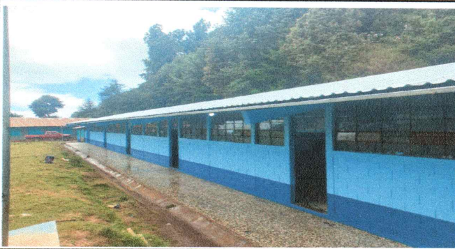
Foto1: Sustitución de lámina
