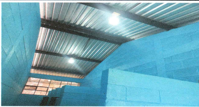
Foto 3: Reparación de cableado eléctrico
