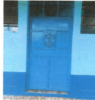
Foto 2: Mantenimiento de puertas
