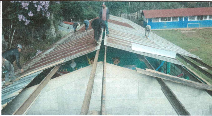
Foto1: Sustitución de lámina
