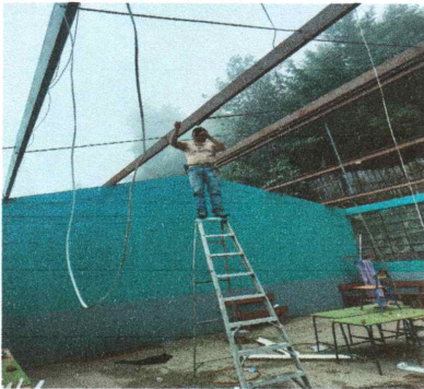
Foto 3: Reparación de cableado eléctrico
