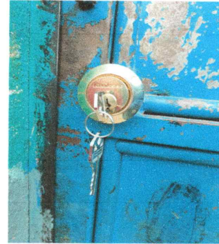
Foto 2: Mantenimiento de puertas
