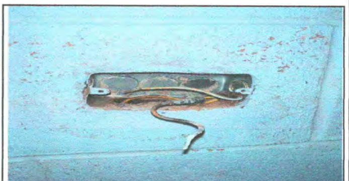
Foto 6: Inexistencia y deterioro de interruptores
