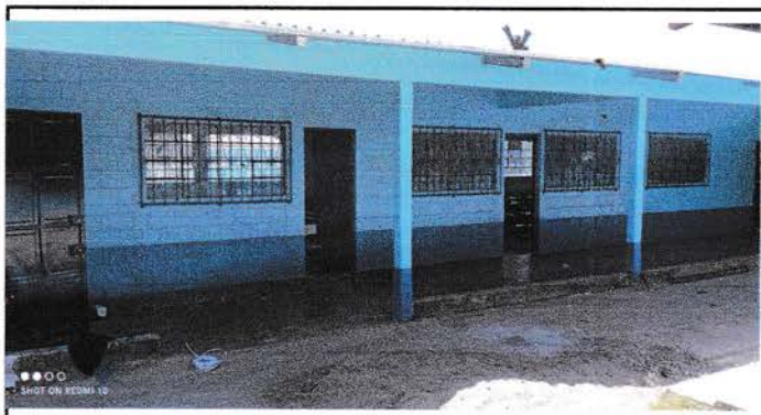
Foto 3: Pintura en muros interiores y exteriores.
