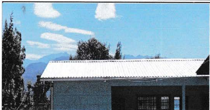
Foto 1: Sustitución de lámina, por lámina troquelada aluzinc.
