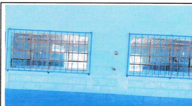
Foto 4: Sustitución de vidrios.
