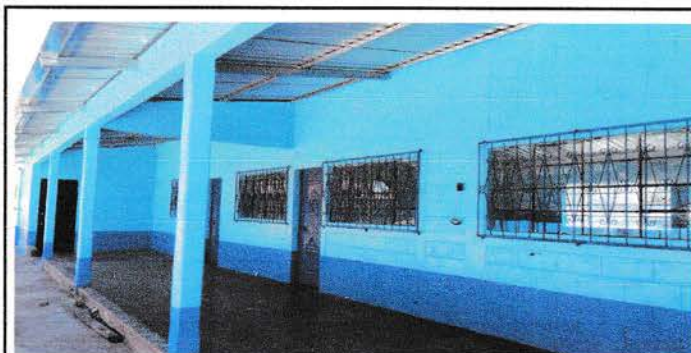
Foto 5: Sustitución de puertas de metal.
