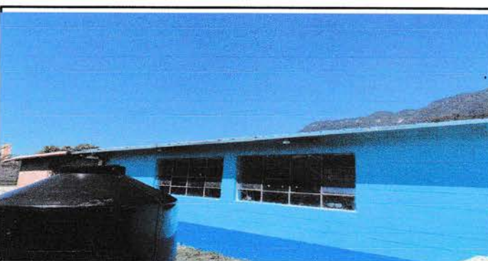
Foto 6: Sustitución de canal de pvc a metal.
